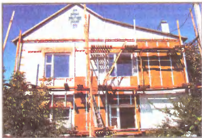
Наружное утепление несущей кирпичной стены плитами «IZOVOL»(Ст) с применением металлического каркаса под виниловый сайдинг
