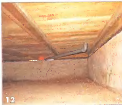
Магистраль смонтирована и закрыта крышкой
