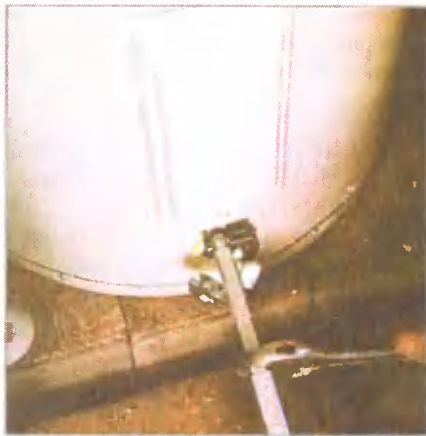
Стандартный сливной кран установить довольно легко. Разводным ключом с изогнутым удлинителем можно просто вывернуть дренажный кран из пластмассовой втулки
