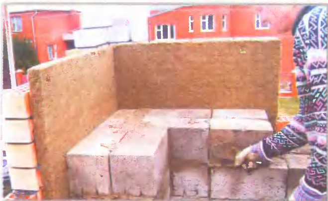
Трёхслойная стена из керамзитобетонных блоков и кирпичей с утеплением плитами «IZOVOL»(Ст) и облицовкой кирпичом
