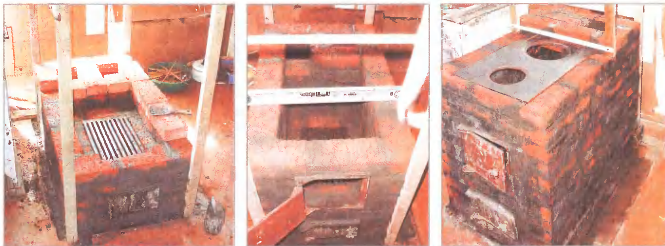
Рабочие моменты строительства печи. Кладка углов ведётся по направляющим рейкам
