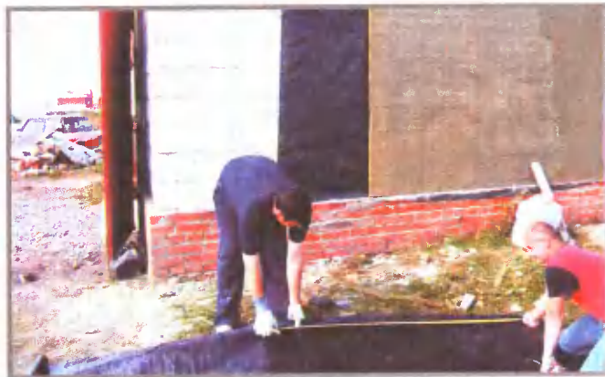
Утепление стены из пенобетонных блоков плитами «IZOVOL»(Ф) со штукатурным покрытием
