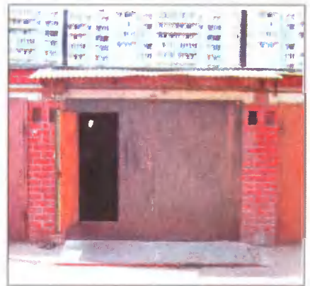
Высокий порог защищает от проникновения в гараж дождевой воды и образованию луж около ворот, а широкий козырёк защищает ворота от осадков
