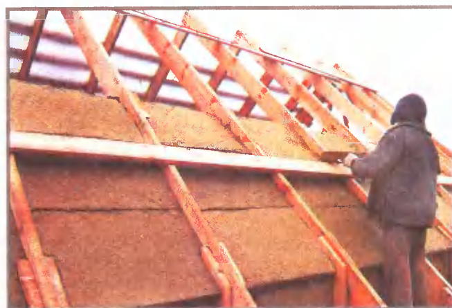
Утепление двускатной крыши плитами «IZOVOL»(Ст)
