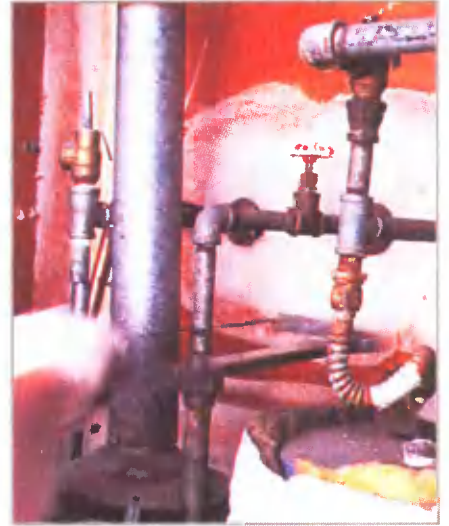
При замене водонагревателя новым старые трубы проще всего перепилить ножовкой
