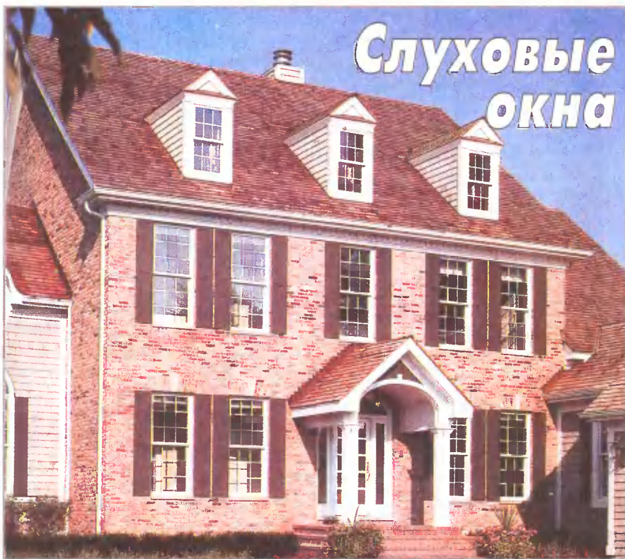
Три двускатных слуховых окна, размеры которых согласуются с размерами этого современного жилища в колониальном стиле, обеспечивают освещение и вентиляцию мансарды. Уклон крыш этих слуховых окон идентичен уклону главной крыши. Их подъёмные окна аналогичны окнам в главной части жилища
