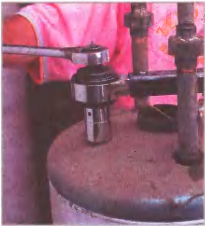
Демонтаж старого анодного штыря. Из-за сильной коррозии резьбовые соединения бывает трудно разобрать. Специальный ключ, создающий необходимый момент, облегчит эту работу
