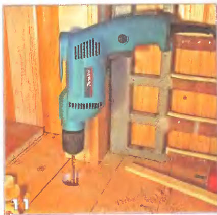
Разметка отверстия в чёрном полу
