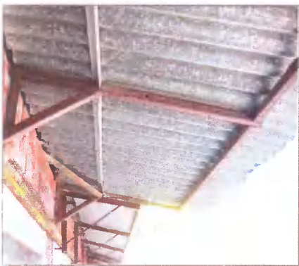
Кронштейны для навеса сделаны из квадратной трубы и уголка. Внешняя часть из трубы смотрится симпатичнее, а уголок удобнее крепить к стене гаража
