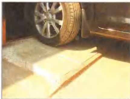
Тротуарные плиты пандуса перед моим гаражом уложены между двумя швеллерами на раствор. Такой бандаж обеспечивает необходимую жесткость и фиксирует плитку от перемещений
