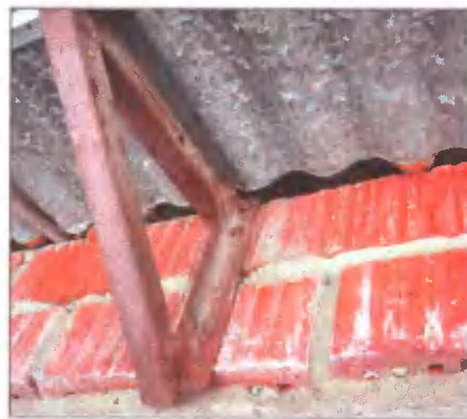
Я сделал два правых и два левых кронштейна. Их конструкция позволяет прикрепить каркас к стене, вворачивая шурупы шуруповёртом, либо забивая дюбель-гвоздь с помощью обычного молотка
