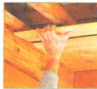
Сосновая ввгонка с готовыми шпунтовыми соединениями скрывает каркас крыши
