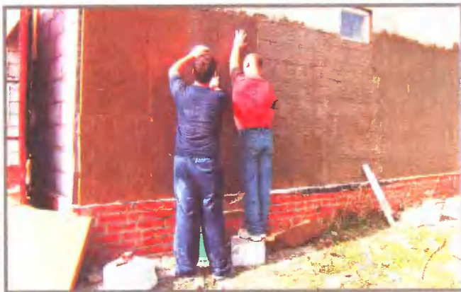
Утепление стены из пенобетонных блоков плитами «IZOVOL»(Ф) со штукатурным покрытием
