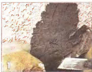
Известково-цементную штукатурку, подкрашенную древесным углём, наносят на основу слоем толщиной около 1 см
