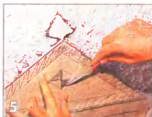
Примерно через 15 мин можно процарапать шилом линии рисунка. Нижний слой штукатурки, имеющий тёмный оттенок, обнажают с помощью металлического или деревянного шпателя
