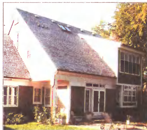
Широкое односкатное слуховое окно соответствует стилю этого коттеджа, покрытого плоской кровельной плиткой. Устройство слухового окна является частью реконструкции дома, которая включает создание эркера на первом этаже. Нижняя часть слухового окна опущена ниже свеса крыши, что является элементом украшения внешнего облика здания
