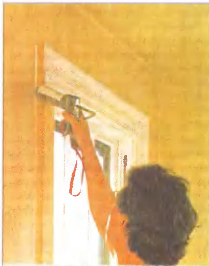
Уплотнение швов. Перед окраской все зазоры между стенами и наличниками (накладками) замазывают окрашиваемым уплотнителем
