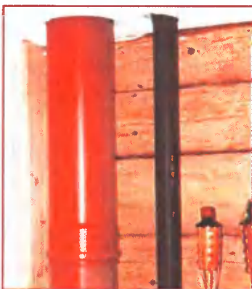
Трубы водопровода и канализации выполнены из некорродирующих материалов
