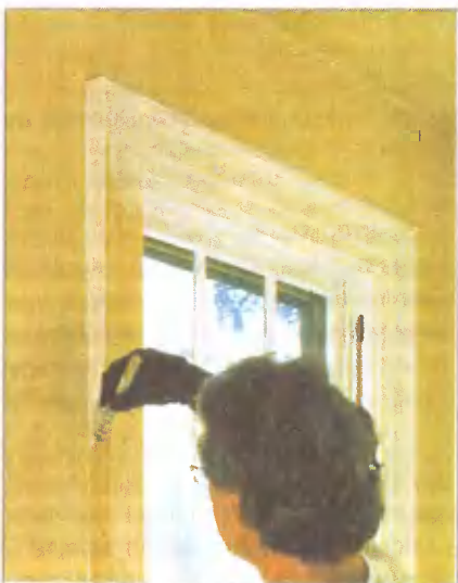
Последующий слой краски следует наносить на предыдущий слой внахлест. Начиная с грунтовочного слоя, нанесённого на наличники и накладки, каждый слой краски должен немного перекрывать смежный участок — в этом случае тон покрытия будет более равномерным
