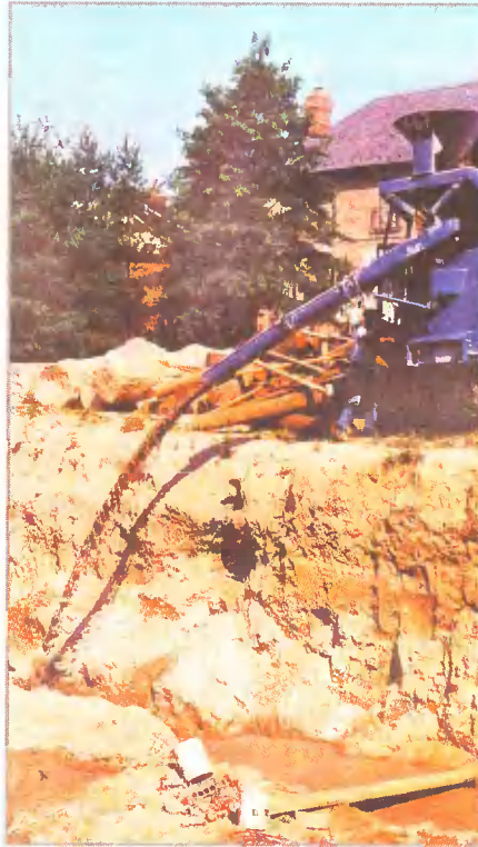
Когда бетон беспорядочно заливают с высоты более полутора метров, заполнитель может осесть на дне. Это серьезно снижает прочность бетона
