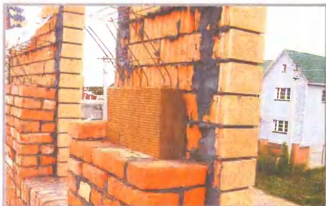
Трёхслойная стена из керамзитобетонных блоков и кирпичей с утеплением плитами «IZOVOL»(Ст) и облицовкой кирпичом
