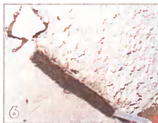
На влажной штукатурке, пользуясь штепелем или валиком, ...
