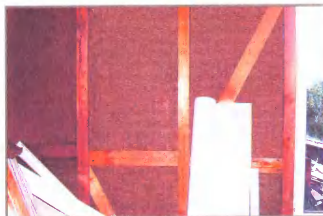
Утепление каркасных конструкций
