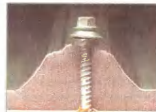
Щели между обрешетинами и рёбрами кровли я герметизировал с помощью полосок пенопласта
